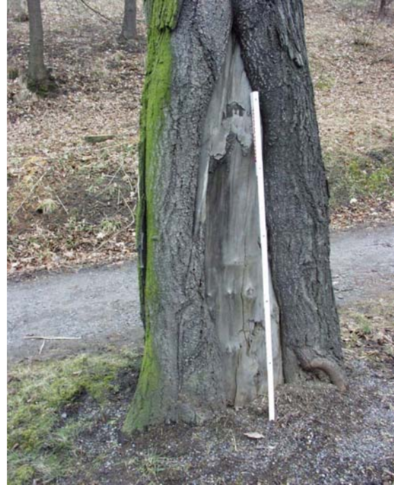
Abbildung 14: Anfahrtschaden mit seitlichen Überwallungswülsten
